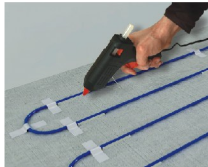
Установка нагревательного кабеля ELEKTRA DM горячим клеем
